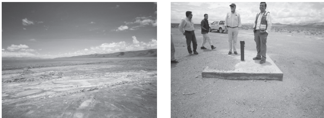
Fig. 3 カウチャリ塩湖の外観とかん水をくみ上げるための配管
