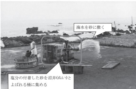
図 1-2 揚浜式塩田における製塩の様子
