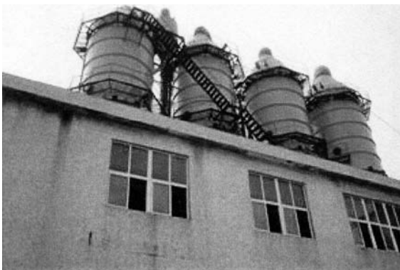
写真9 プラントの外観
