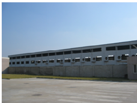
図9 二基目の工場(建設中)
