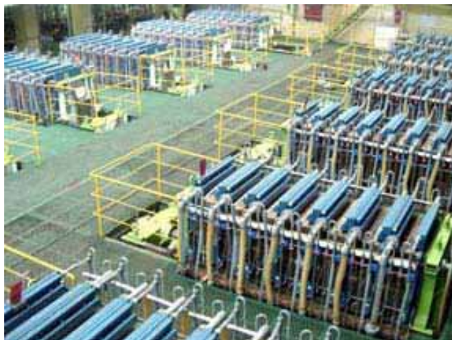
図-9 現在のイオン交換膜電気透析装置
